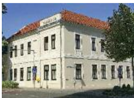
Die Trausdorfer Volksschule nach der Sanierung von Dach und Fassade im Jahr 2012.
